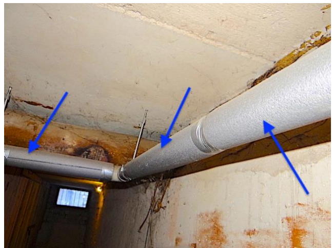
70. att. Aukstā ūdens cauruļvads izolēts ar pretkondensāta izolāciju
