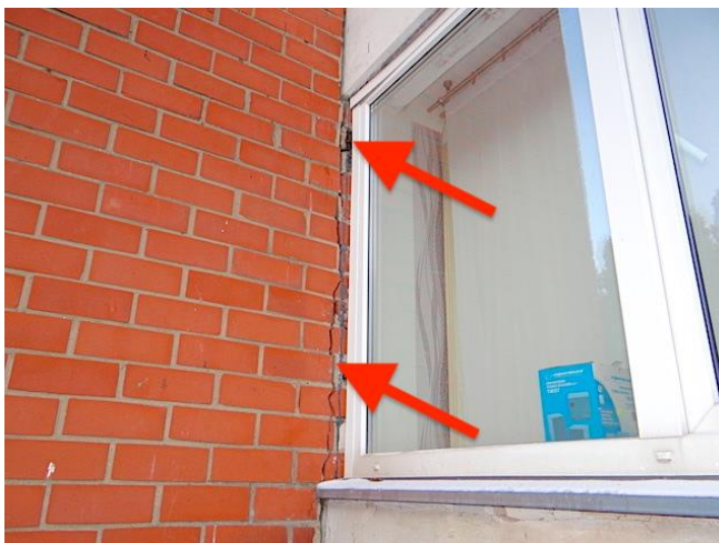
17. att. Plaisa lodžijas pilastrā ēkas Rietumu pusē
