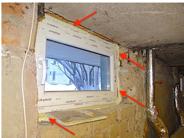
61. att. Pagraba logs no iekšpuses siltummezglā bez apdares
