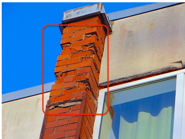
16. att. Pilastra ķieģeļu mūra bojājumi
