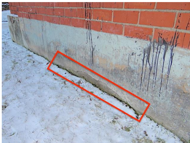
6. att. Atslāņojies cokola apmetums
