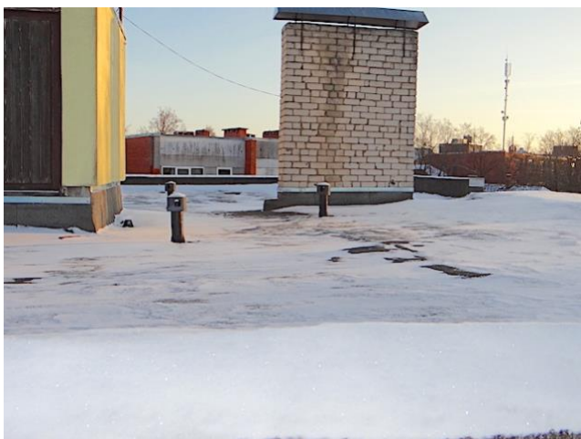
35. att. Jumta segums ar aeratoru izvadiem, ventilācijas izvads
