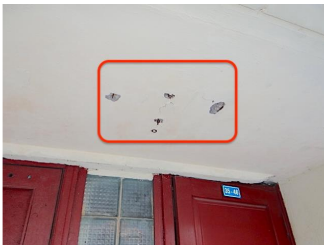
48. att. Ieejas jumtiņam betona izdrupumi
