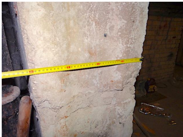
3. att. Dzelzsbetona pamatu bloki
