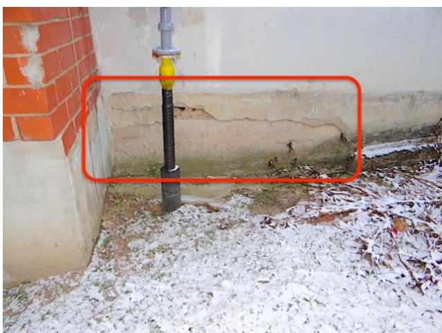
7. att. Atslāņojies cokola apmetums
