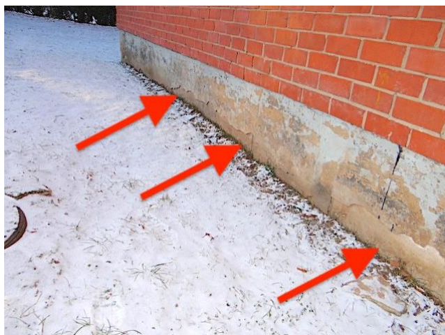
10. att. Atslāņojies cokola apmetums
