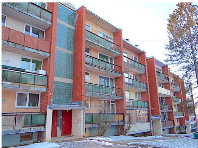
41. att. Lodžijas Austrumu fasādē
