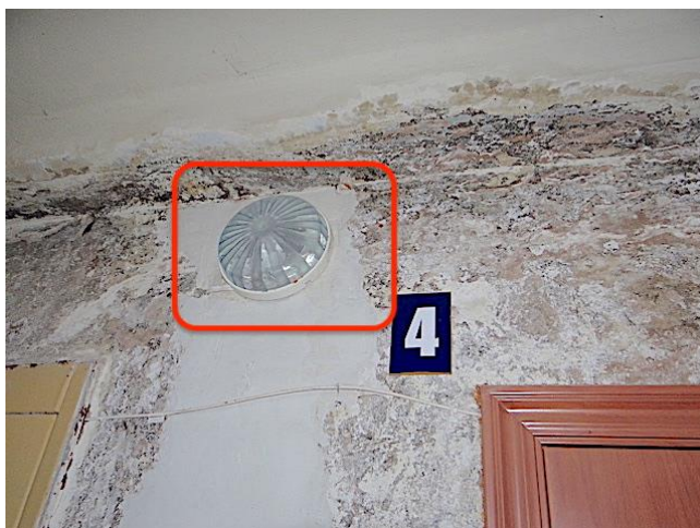
94. att. Kāpņu telpās nomainīta armatūra
