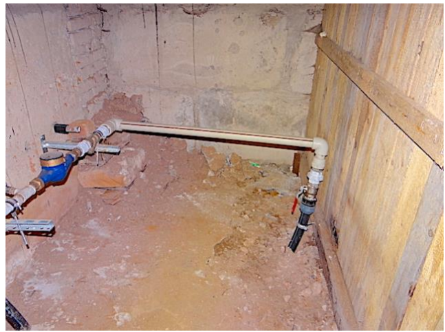
68. att. Aukstā ūdens ievads
