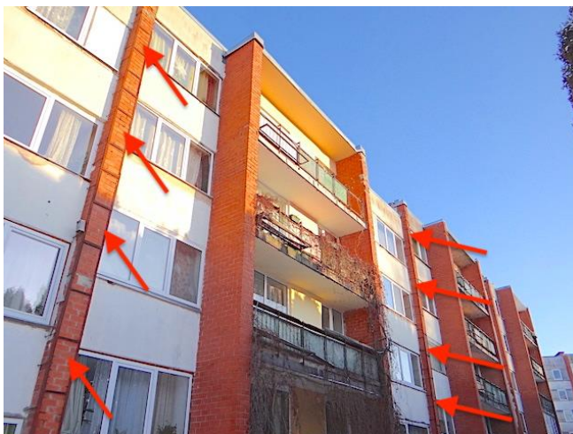
23. att. Pastiprināti pilastrī ēkas Rietumu pusē
