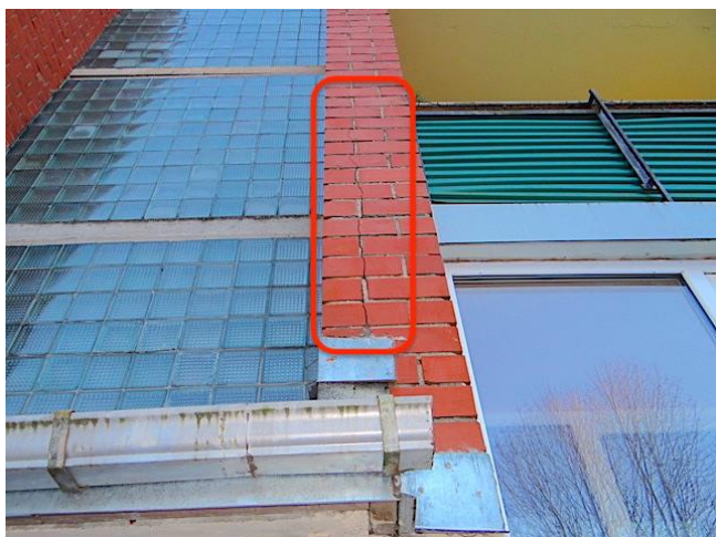
21. att. Plaisa lodžijas – kāpņu telpas sienas pilastrā ēkas Austrumu pusē
