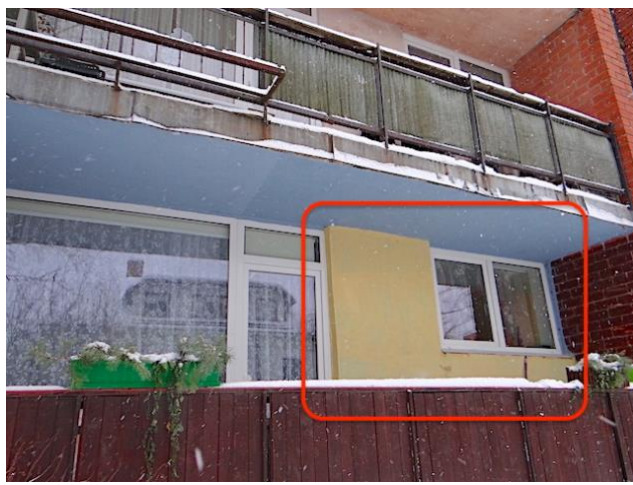
32. att. Gāzbetonu bloku aizmūrējums starp logiem ēkas Austrumu pusē
