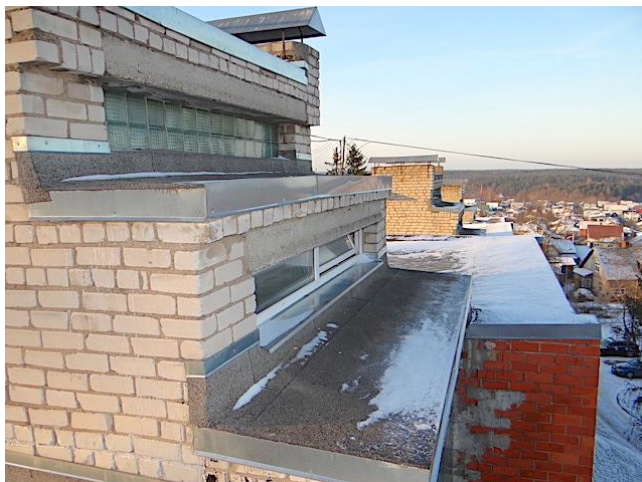
34. att. Kāpņu telpas jumtiņi ar segumu.
