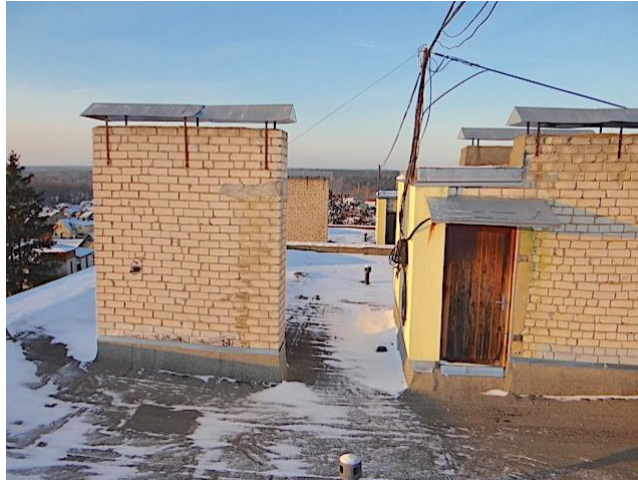
38. att. Junta segums, ventilācijas izvads un kāpņu telpas ārsienas
