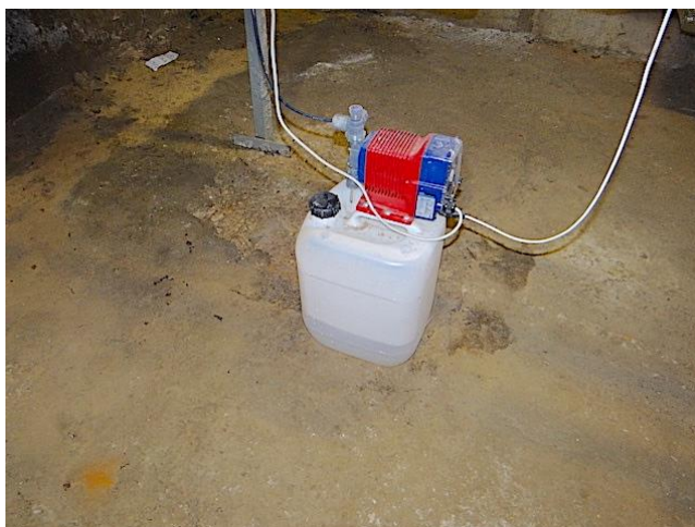
80. att. Dozators siltummezglā
