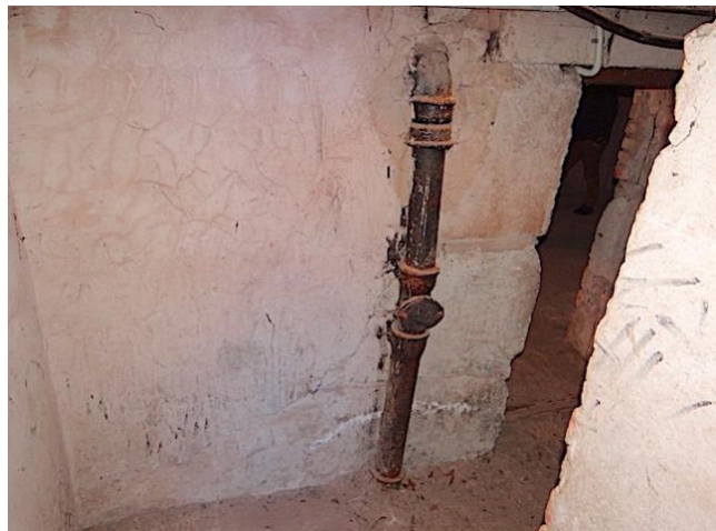
75. att. Ķeta kanalizācijas caurules
