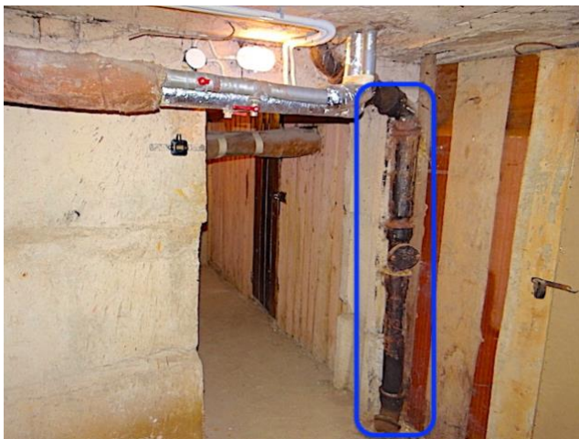
74. att. Ķeta kanalizācijas caurules
