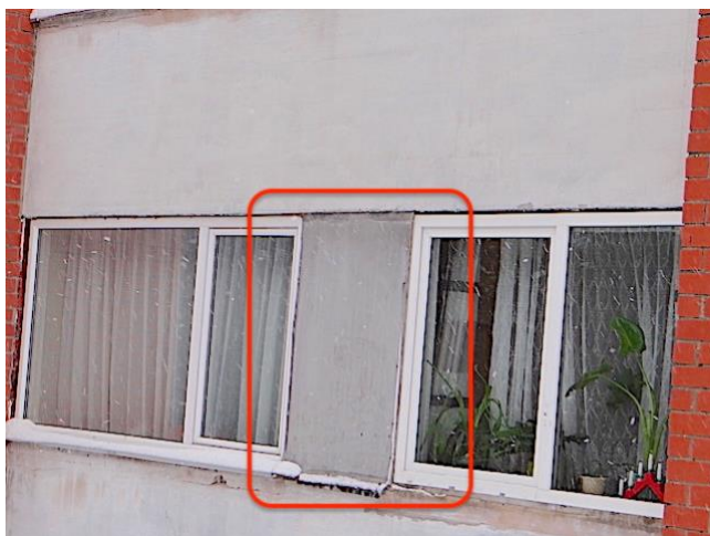
31. att. Šīfera loksne nosedz starpailu ēkas Rietumu pusē
