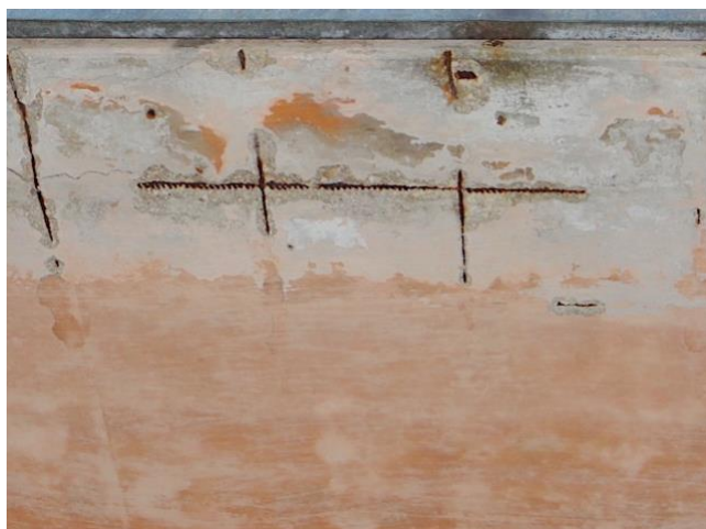
44. att. Korodējis stiegrējums
