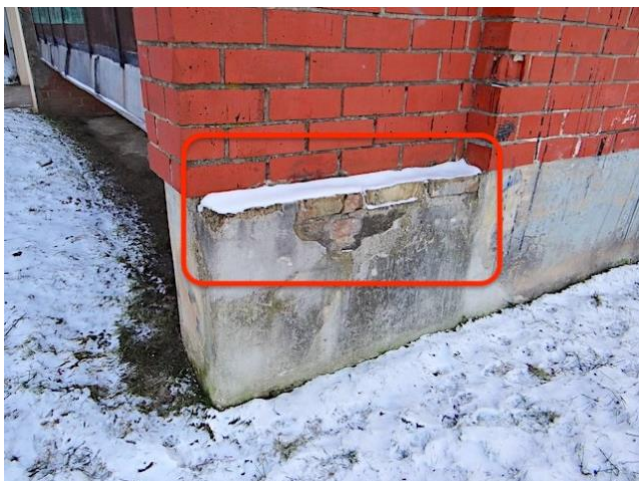
5. att. Atslāņojies cokola apmetums
