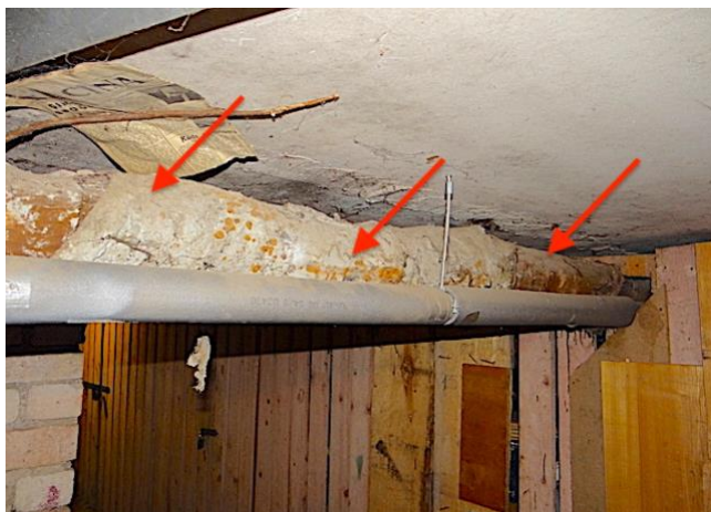
77. att. Karstā ūdens cauruļvads izolēts drēbes apvalkā
