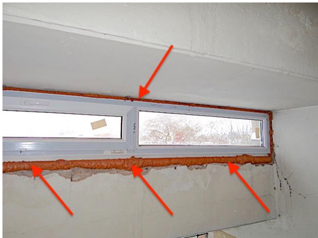
58. att. Uzstādītais PVC logs kāpņu telpā bez ailu apdares
