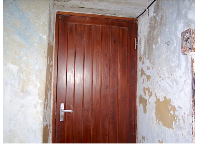
52. att. Kāpņu telpas durvis izejai uz jumtu
