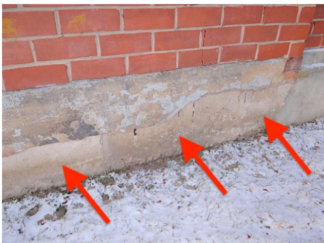
9. att. Atslāņojies cokola apmetums
