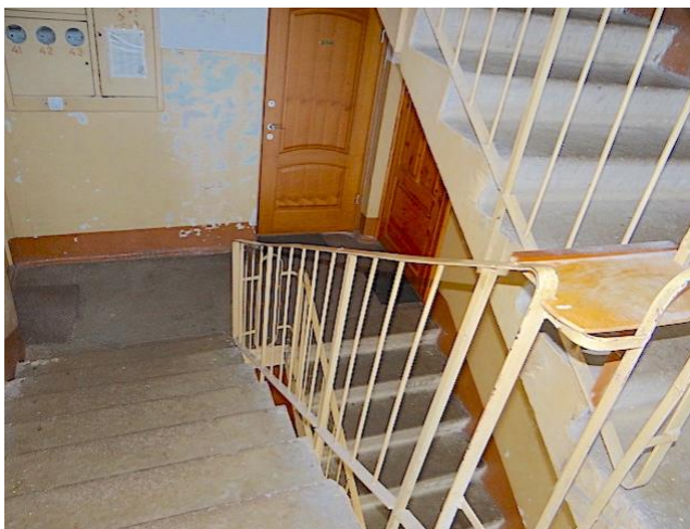
50. att. Saliekamā dzelzsbetona kāpnes, bez margas apdares
