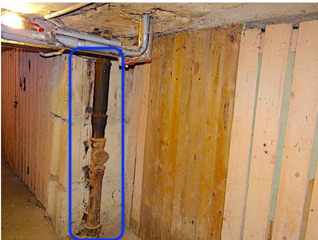
76. att. Ķeta kanalizācijas caurules
