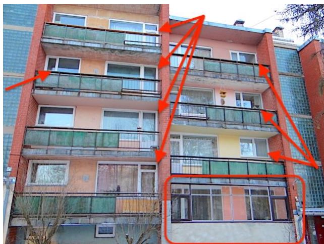
42. att. Lodžijas Austrumu fasādē, dažādi logu daļījumi
