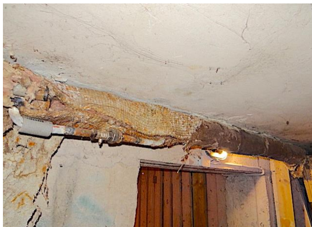
78. att. Karstā ūdens cauruļvads izolēts drēbes apvalkā
