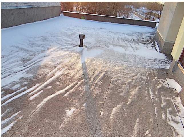
33. att. Jumta segums
