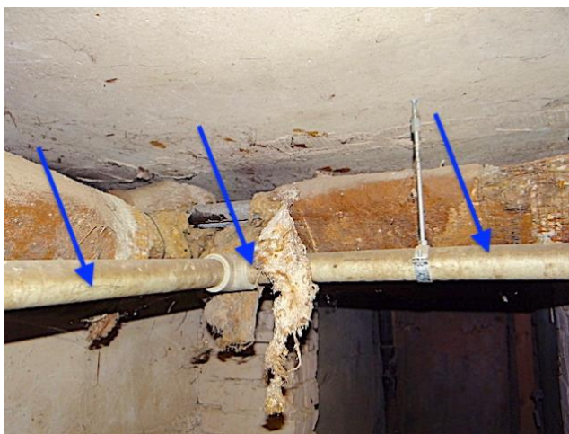
72. att. Aukstā ūdens cauruļvads nav izolēts ar pretkondensāta izolāciju
