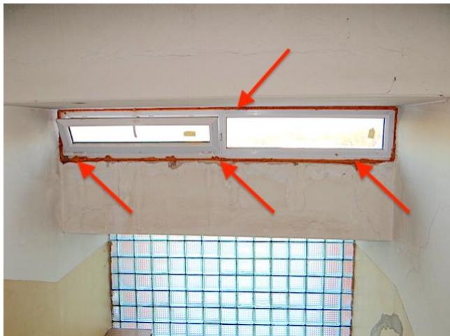
57. att. Uzstādītais PVC logs kāpņu telpā bez ailu apdares
