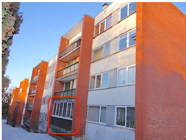
40. att. Aizstiklota lodžija Rietumu fasādē
