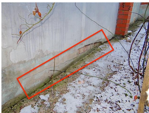
8. att. Atslāņojies cokola apmetums
