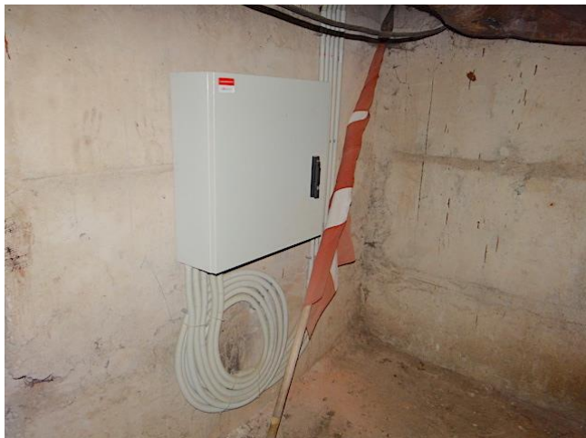
95. att. Lattelecom (TET) vājstrāvas tīklu sadalne pagrabstāvā
