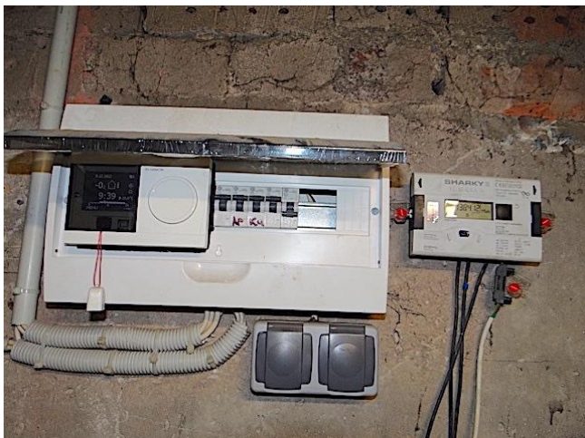
83. att. Siltummezgla automātika
