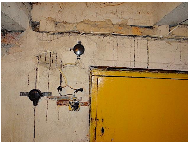
89. att. Elektroinstalācija pagrabstāvā
